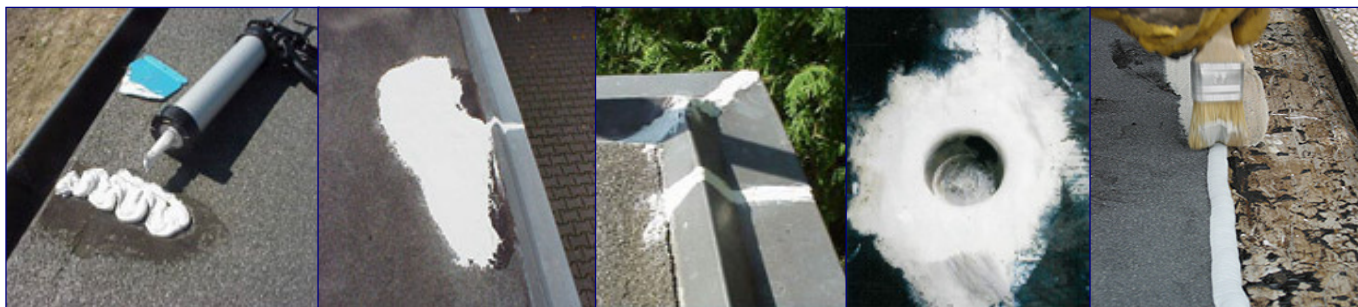
Bild 1+2 Luftblase aufgeschnitten, mit PU-Masse aufgefüllt. - Bild 3, Zinknähte abgedichtet. - Bild 4, ein mit PU-Masse modellierter Gully. - Bild 5, Bitumen – Metallkante Nahtabdichtung
